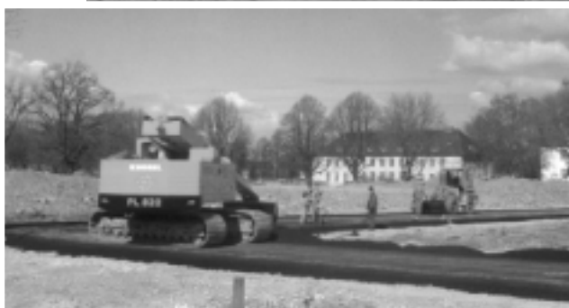
Vauban, 1. Bauabschnitt, 20.3.1998: Die „Baustraßen“ werden angelegt
