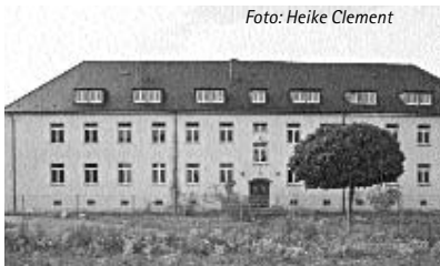
Vorerst vom Abriss verschont
